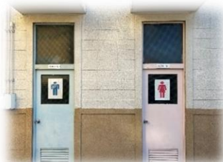
【プール側トイレ】
