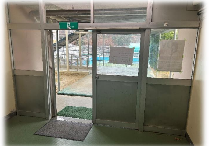
【南館1階 体育館通路扉】
