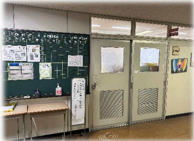
【職員室“後方”扉】
