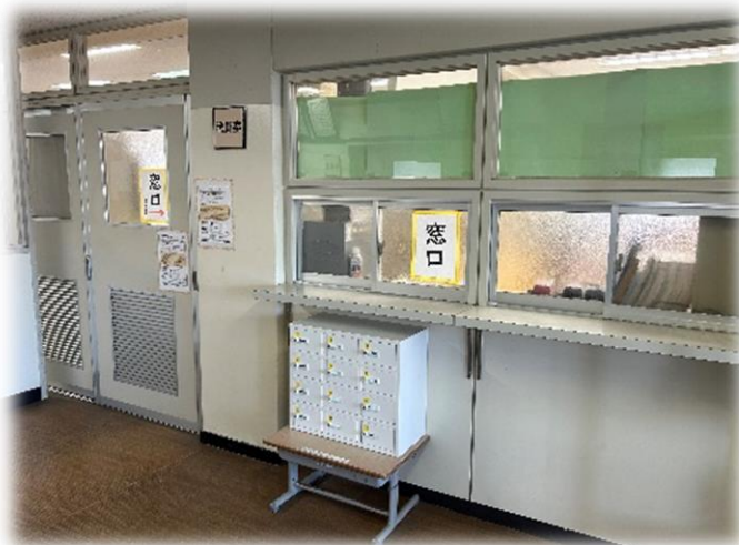
【職員室“前方”扉】
