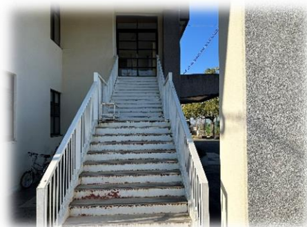
【2階玄関（非常階段）】
