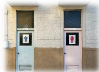
【プール側トイレ】
