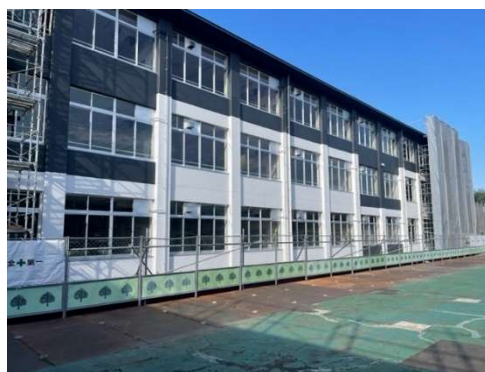
足場が取れ、外壁の塗装が見えてきました。(白と黒、ちょっと赤)
