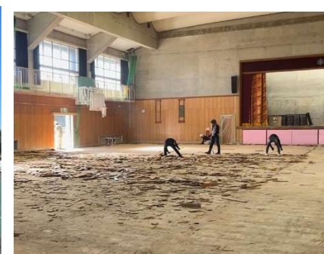
体育館の床の張替え、古い床をめぐっています。
