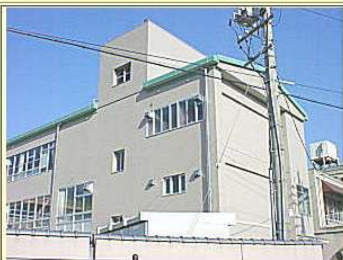
耐震工事により改修された校舎
