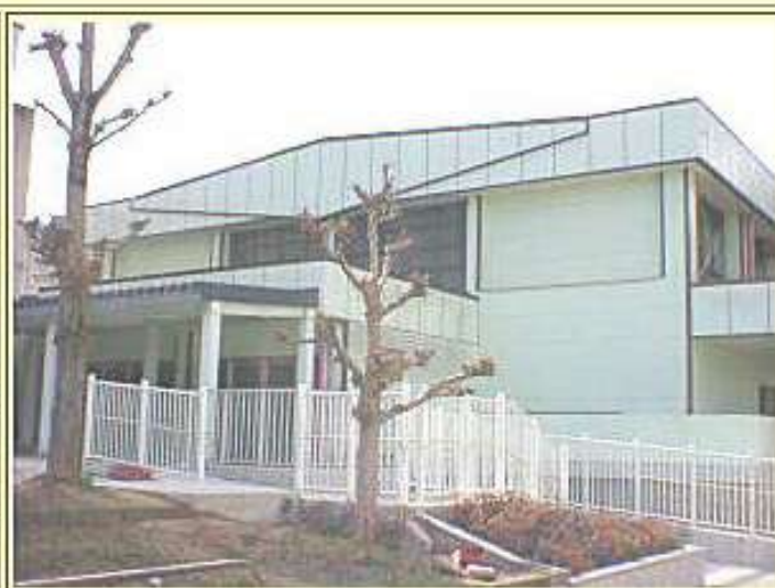
体育館の改修
