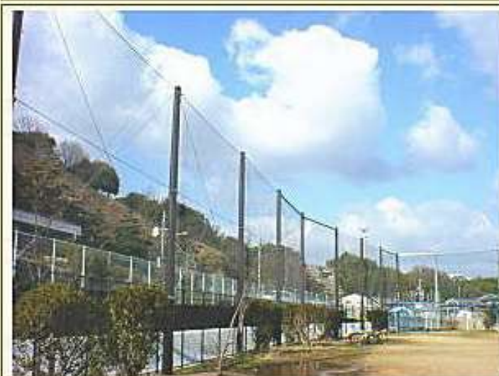
フェンスが新しくなった運動場
